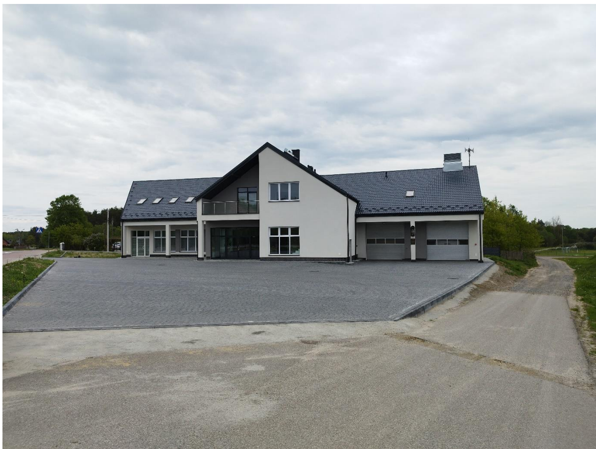
Fot. Wykonane utwardzenie placu przy budynku wielofunkcyjnym w Kopciach
