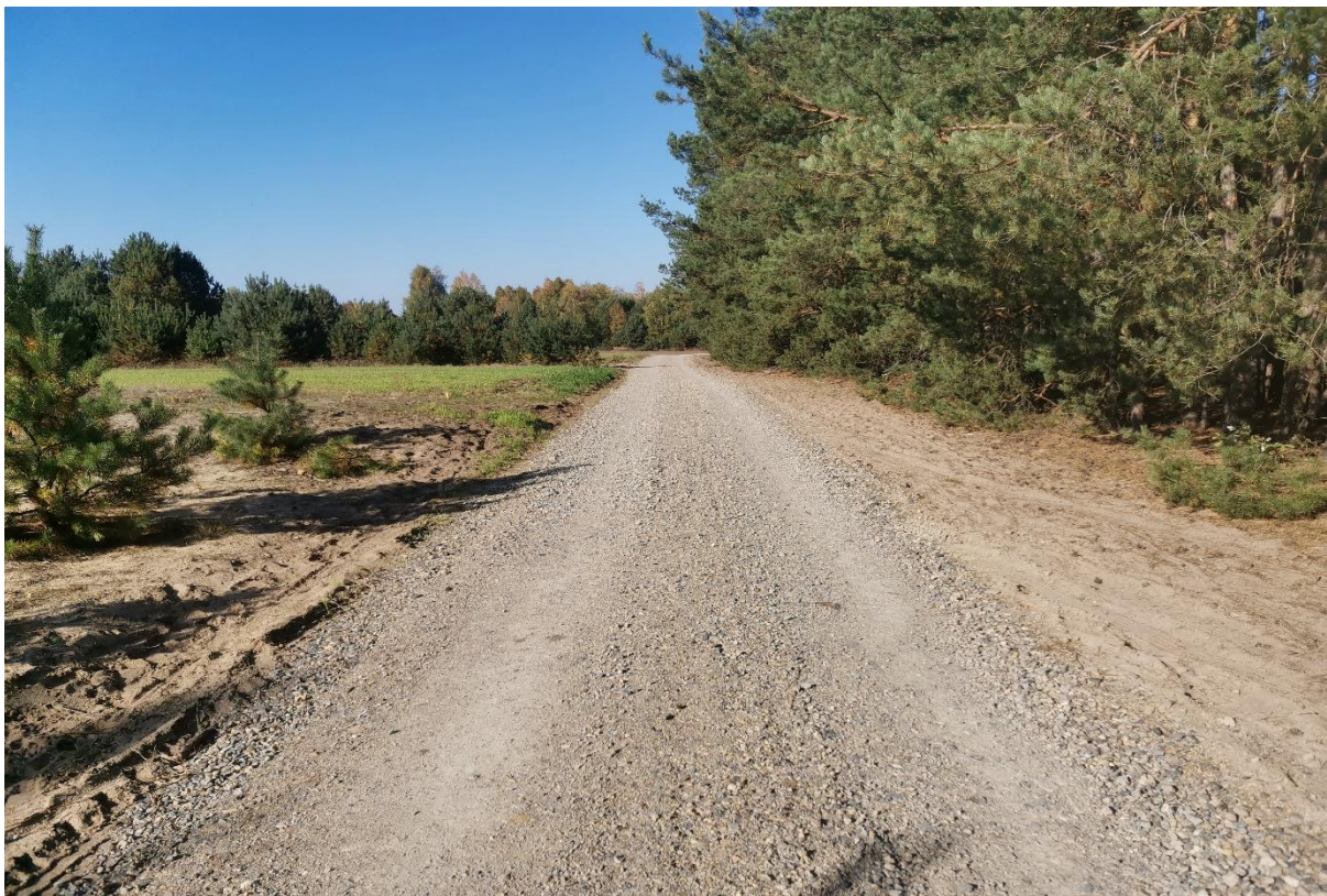
Fot. Wykonana droga dojazdowa do pól w miejscowości Kopcie (dz. nr ewid. 587).
