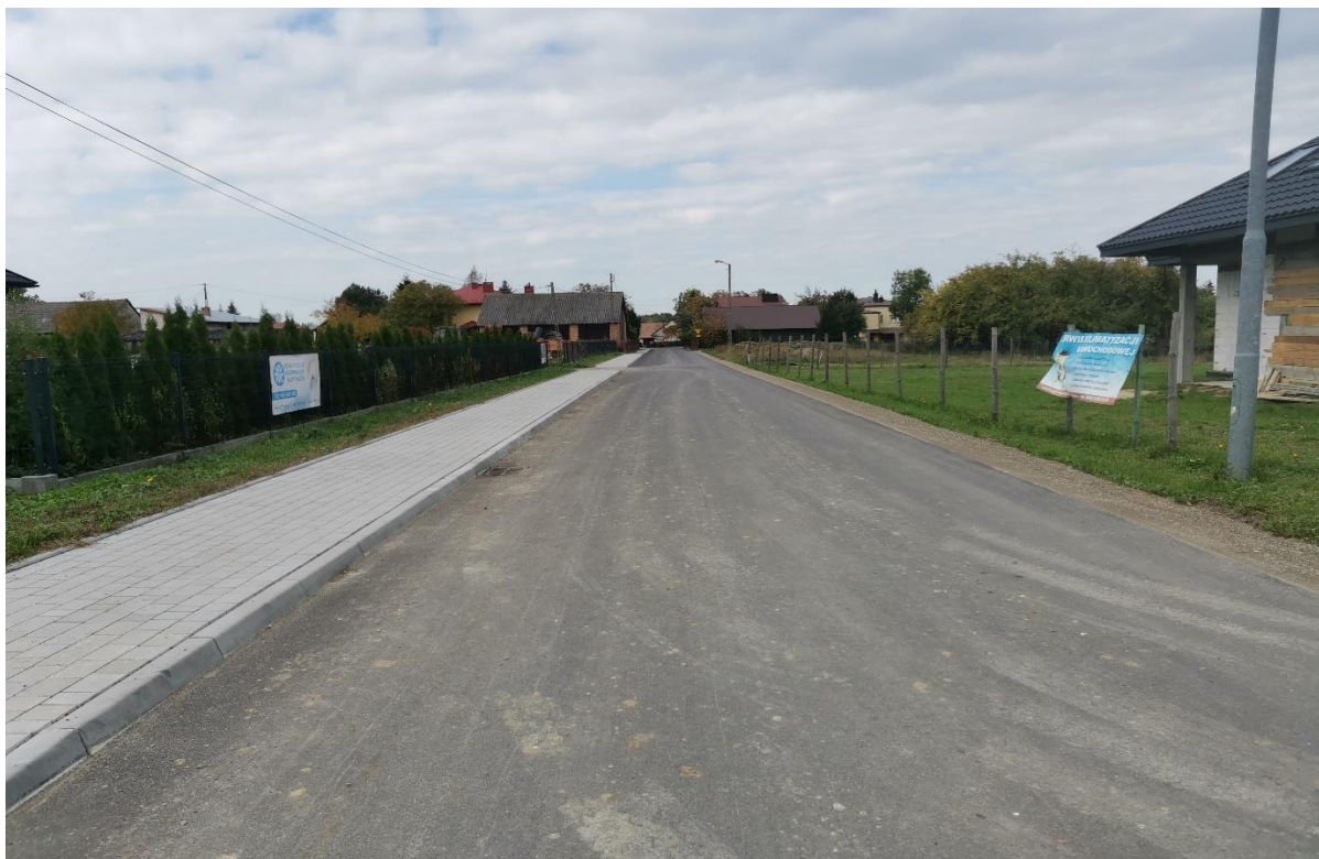
Fot. Wykonany remont drogi nr 104 319 R Nowy Dzikowiec – Ośrodek Zdrowia w miejscowości Nowy Dzikowiec
