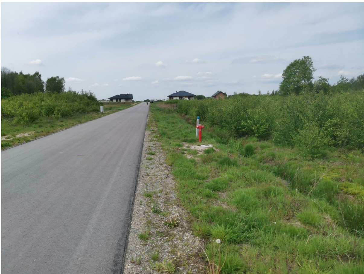
Fot. Wykonana sieć wodociągowa i kanalizacyjna
