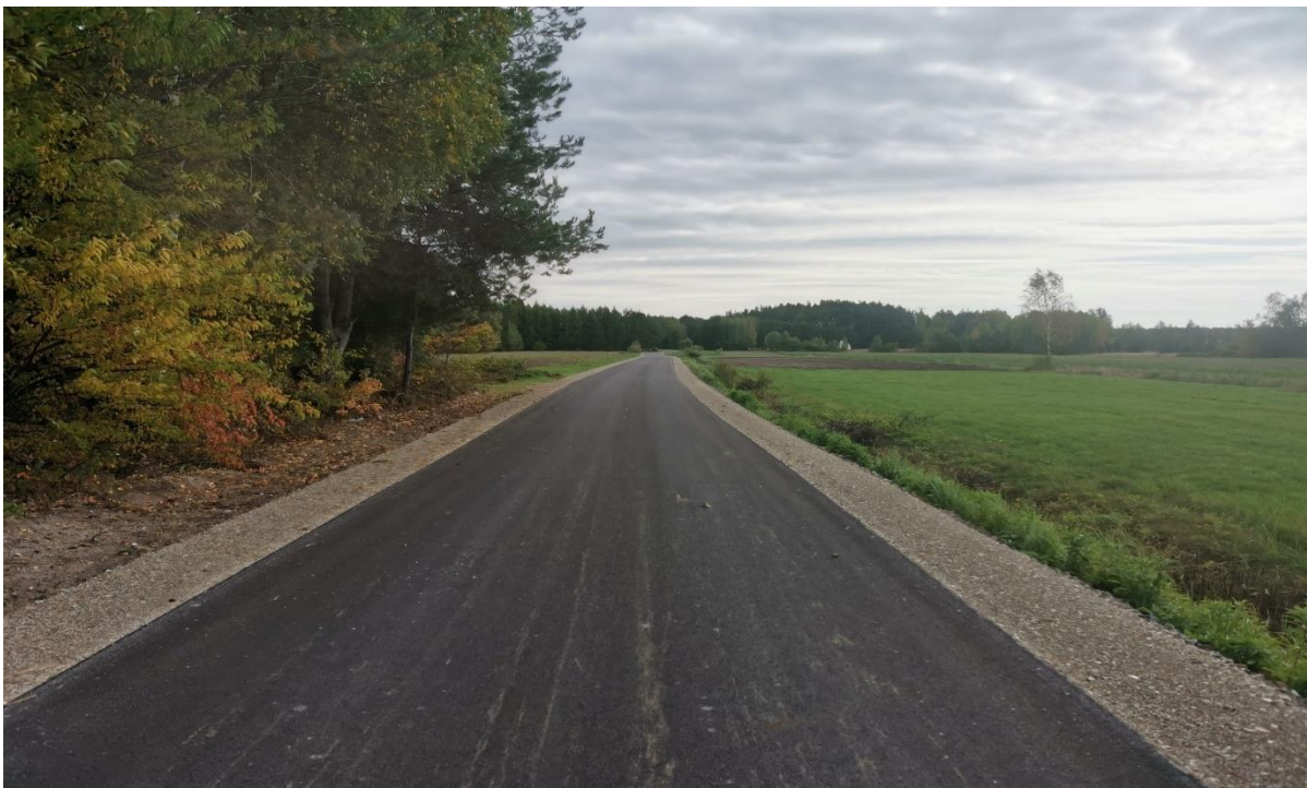
Fot. Wykonana przebudowa drogi Kopcie – Wysokoniwka – Gutowiec w miejscowości Wilcza Wola
