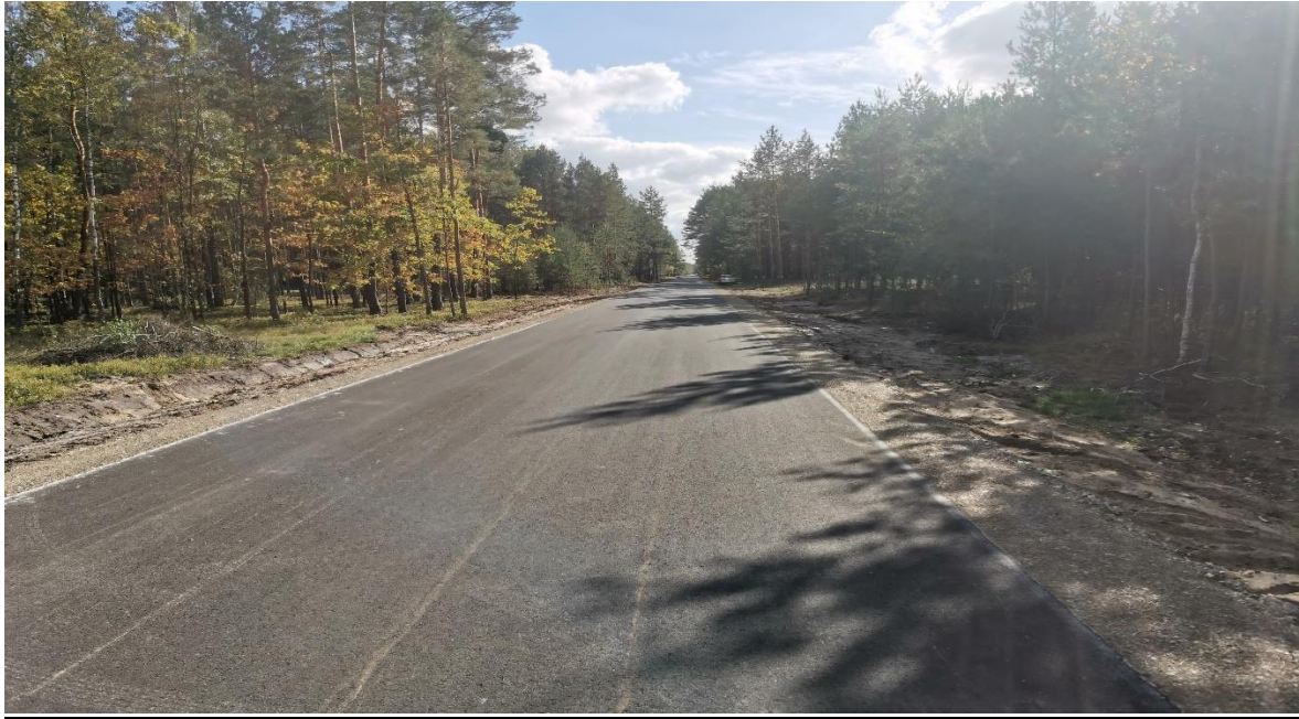
Fot. Wykonana przebudowa drogi w miejscowości Wilcza Wola (dz. nr ewid. 2391/2)
