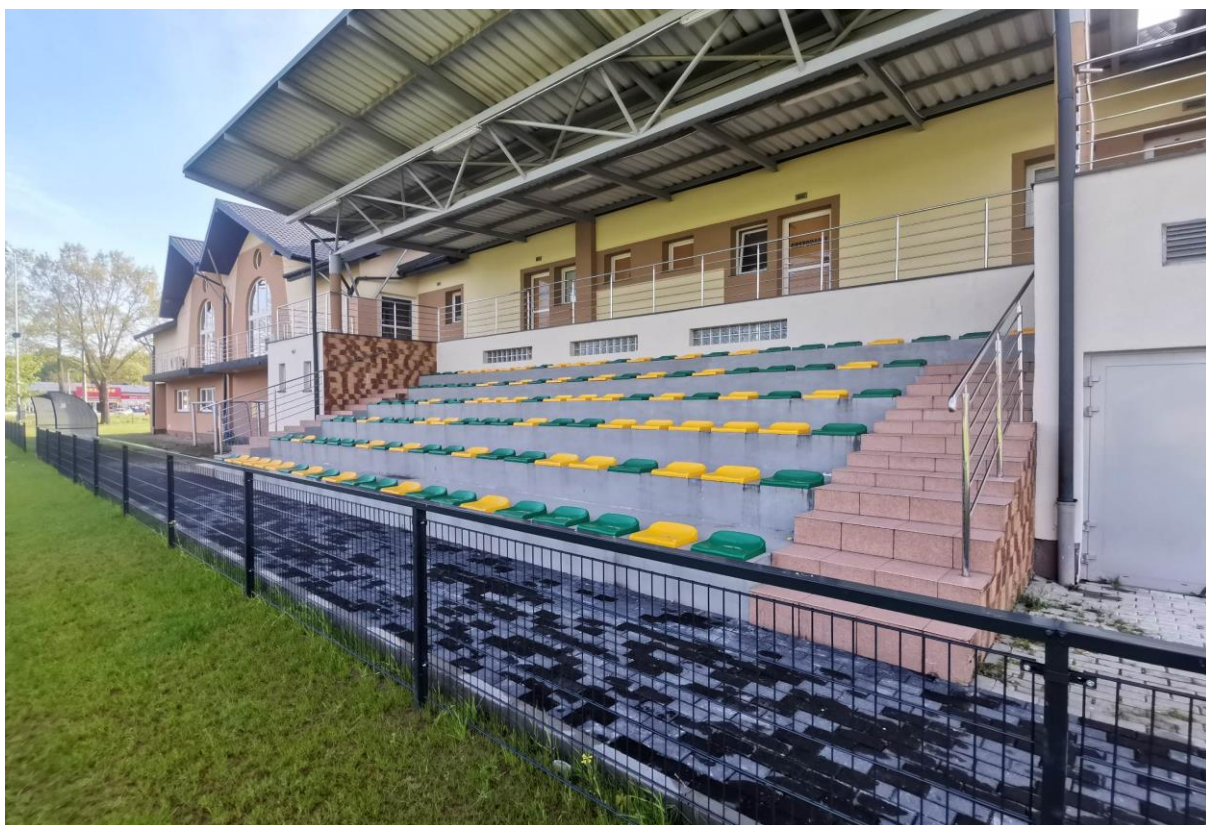
Fot. Wykonane zadanie pn.: „Modernizacja infrastruktury sportowej w miejscowości Dzikowiec”
